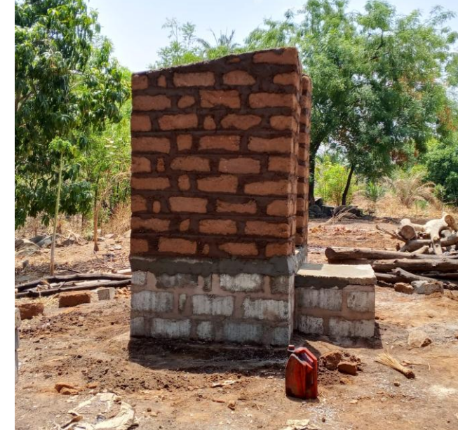
Latrine Ecosan construite dans un ménage à Soumdina
