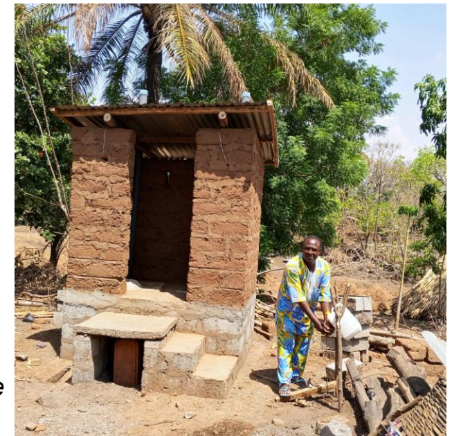
Latrine Ecosan construite dans un ménage à Soumdina
